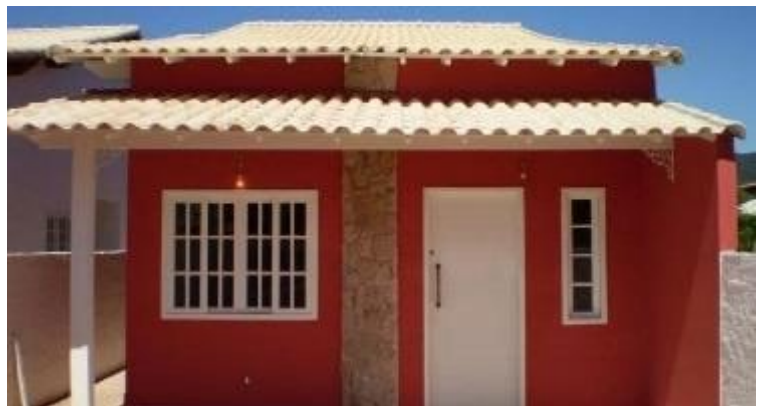
Figura 3 – Casa: vista frontal
